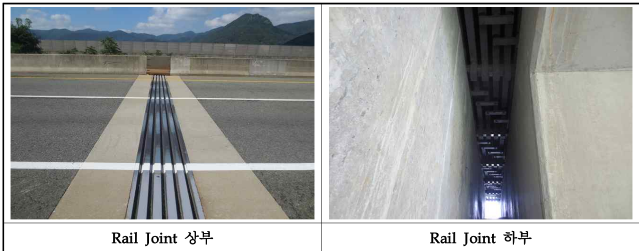
【사진 3.2.12】 신축이음장치 전경(대구)
