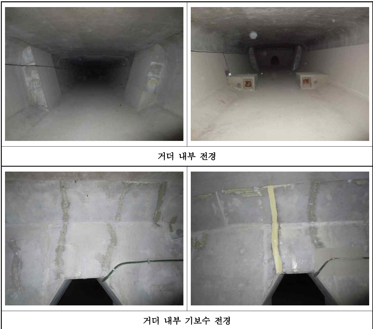
【사진 3.2.3】 거더 내부 전경(대구)
