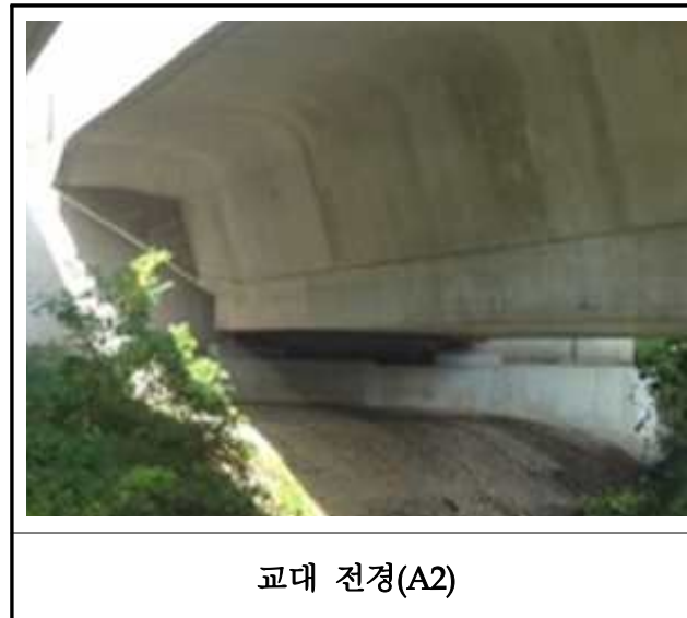
【사진 3.2.5】 교대 전경(대구)
