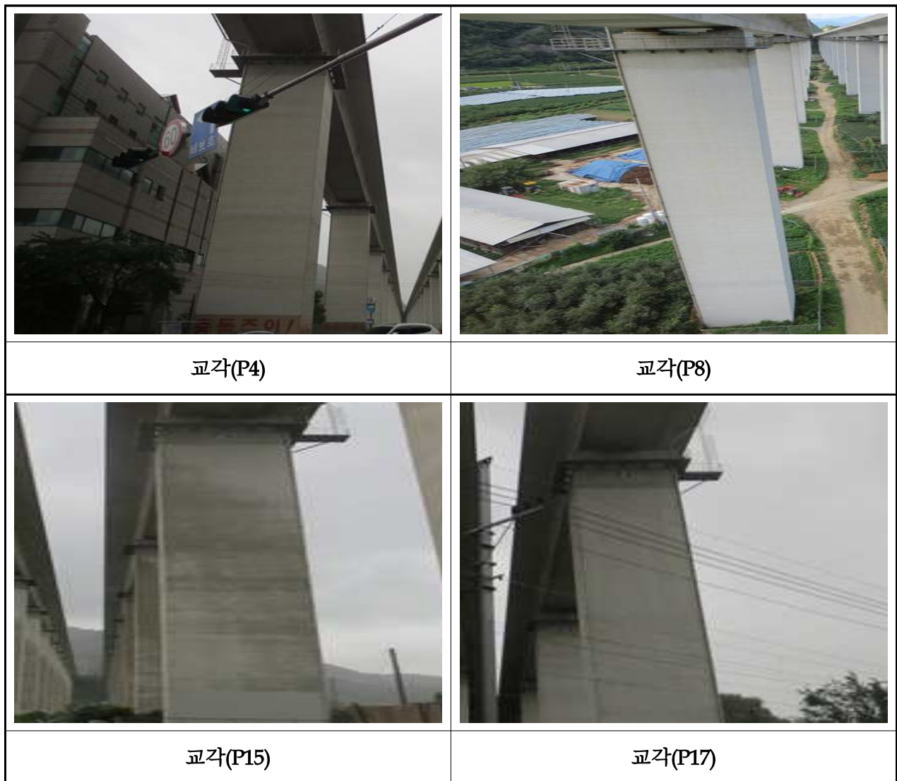
【사진 3.3.7】 교각 전경(부산)
