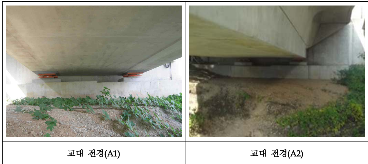
【사진 3.3.5】 교대 전경(부산)
