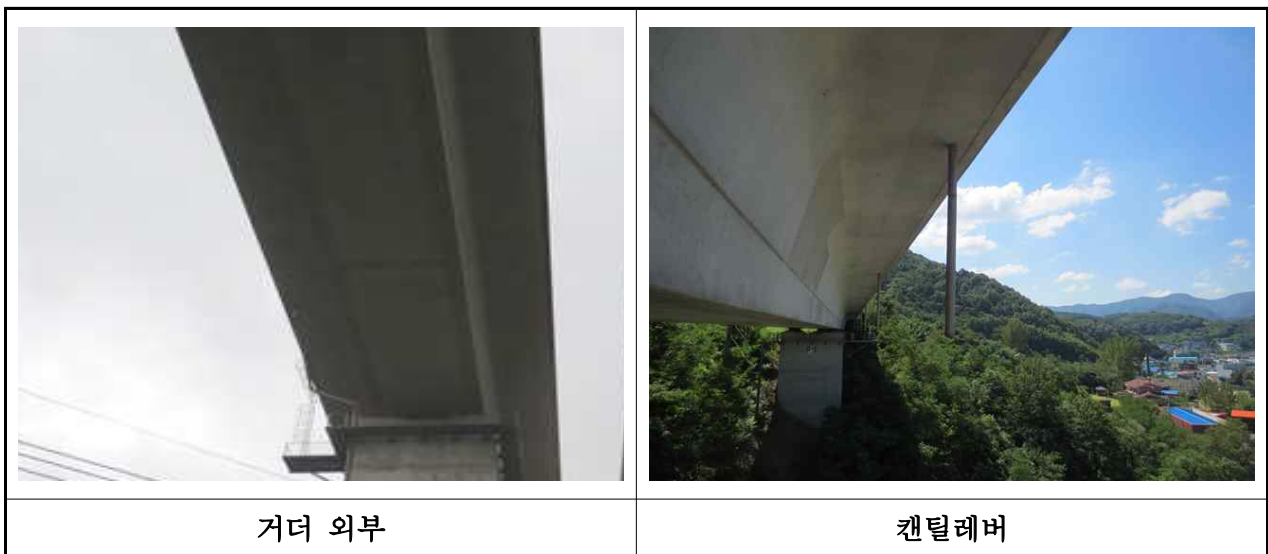
【사진 3.3.1】 거더 외부 전경(부산)
