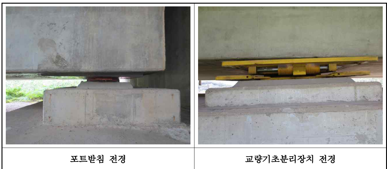
【사진 3.3.9】 교량받침 전경(부산)
