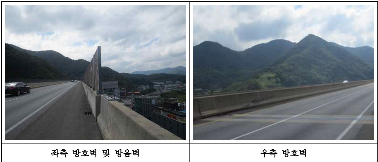
【사진 3.3.19】 난간 및 연석 전경(부산)
