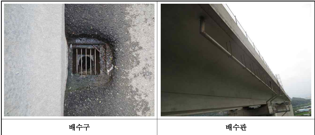
【사진 3.2.17】 배수시설 전경
