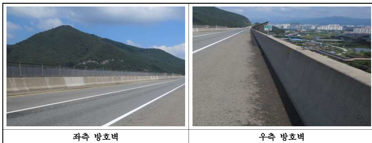
【사진 3.2.19】 난간 및 연석 전경(대구)
