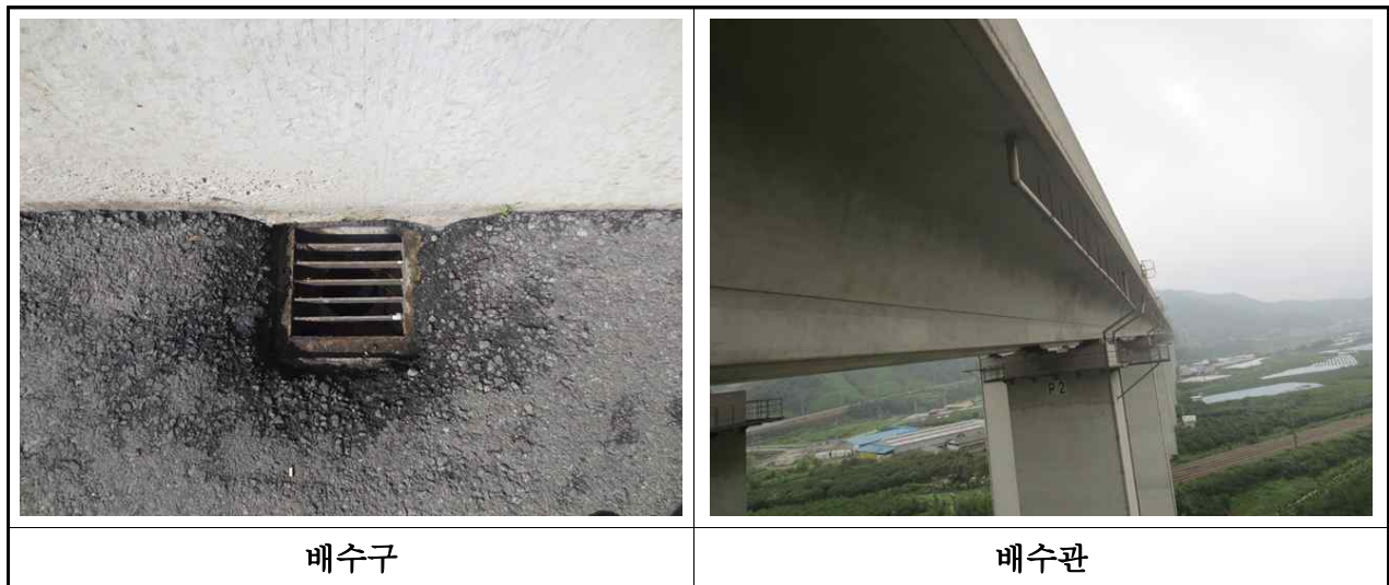
【사진 3.3.17】 배수구 및 배수관 전경
