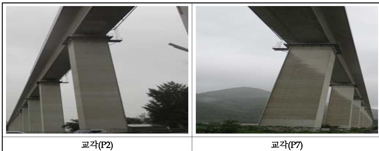
【사진 3.2.7】 교각 전경(대구)
