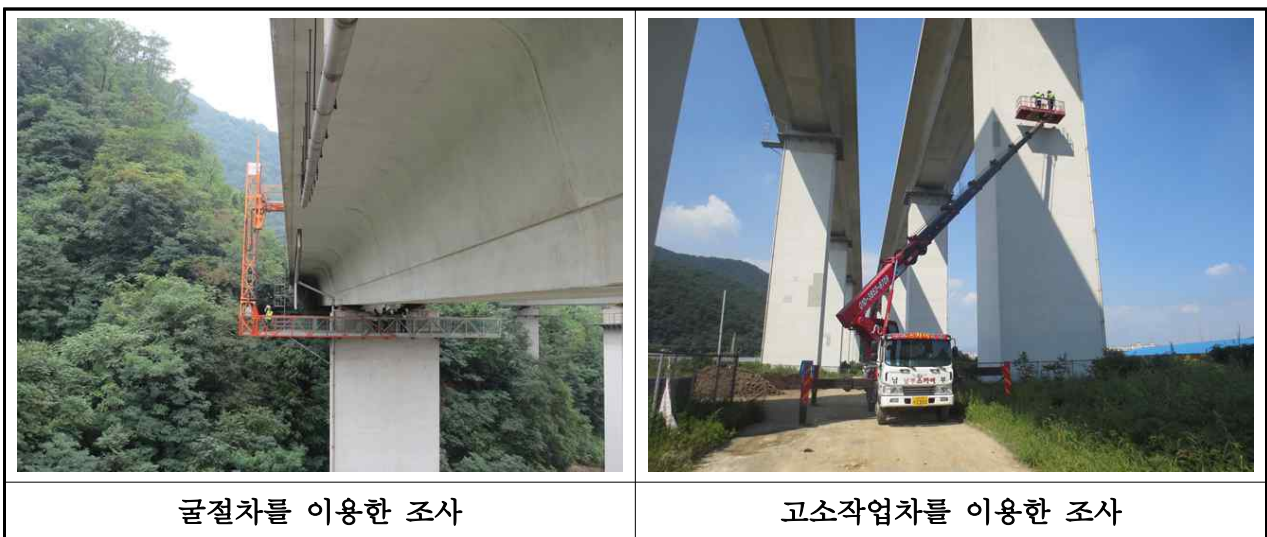
【사진 3.1.1】 교량점검차 이용한 근접 육안조사
