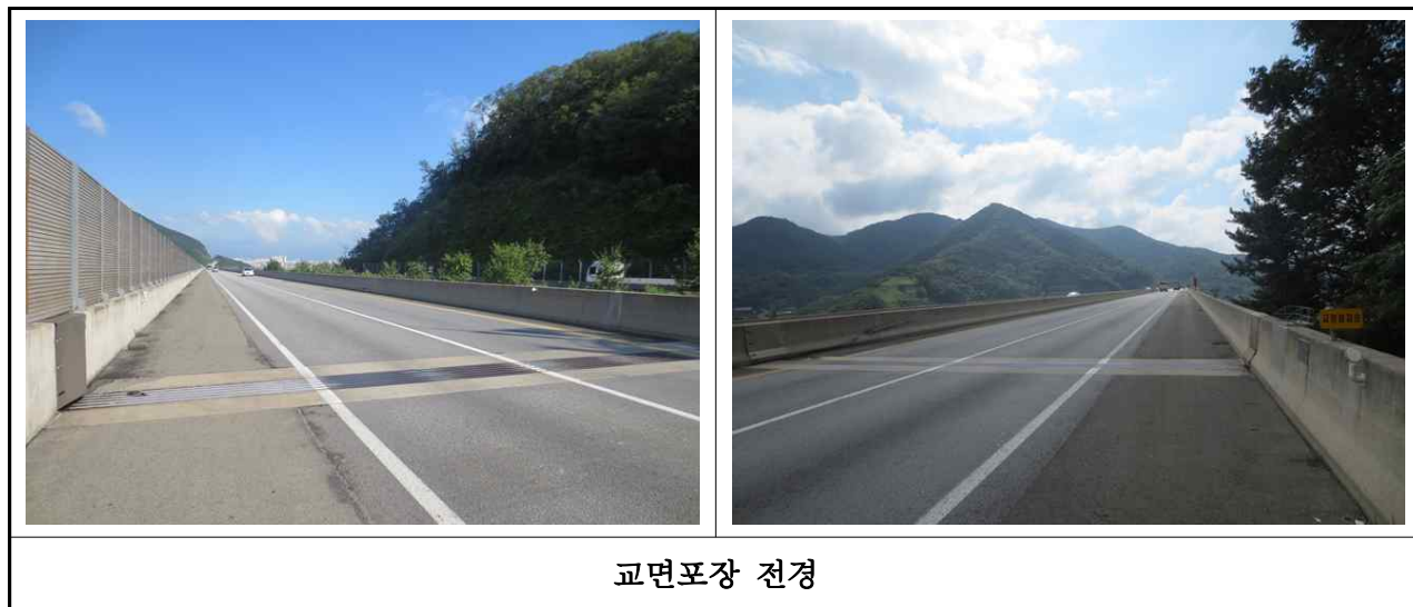
【사진 3.3.15】 교면포장 전경(부산)
