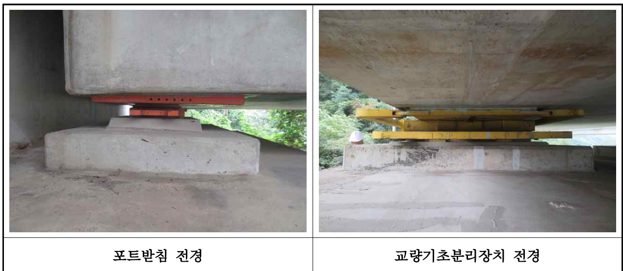
【사진 3.2.9】 교량받침 전경(대구)
